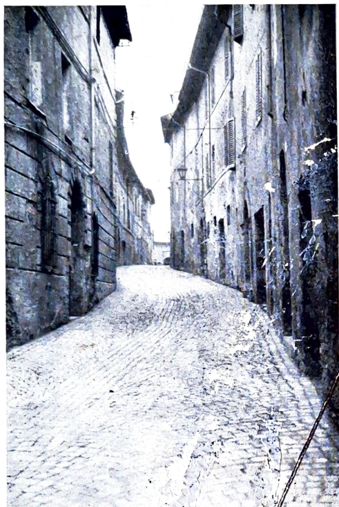
Via Cialdini dopo i lavori di fognatura e pavimentazione.
