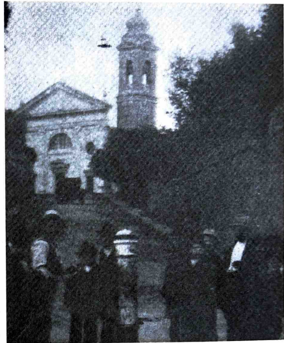
Fig. 22. Montalcino. Una delle prime fontanelle installate con la costruzione dell'acquedotto dalle sorgenti del Vivo d'Orcia posta in Piazza Cavour.
